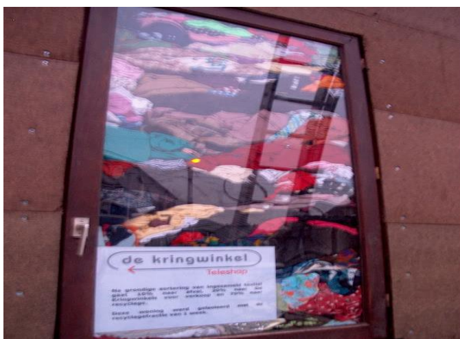
Figuur 2. Foto van een raam in een gevel waarin oude kleren de thermische isolatie verzekeren
