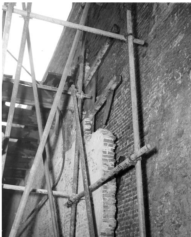
Sloop van Warmoesstraat 96 in 1959. De zijmuur van het houtskelethuis is één steen dik (Monumenten en Archeologie, Gemeente Amsterdam).
