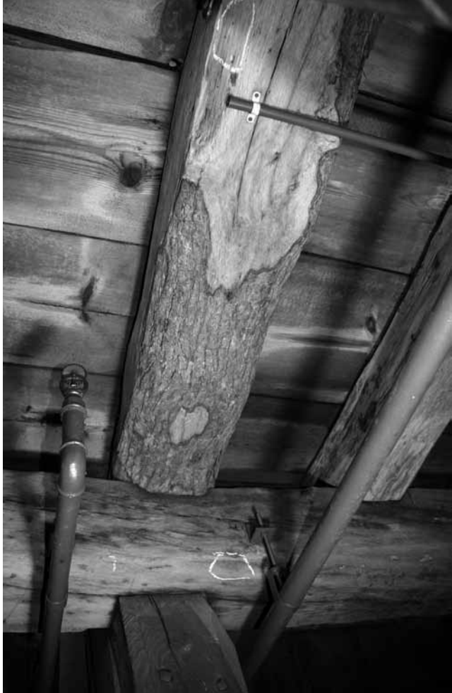
Afbeelding 6: Amsterdam, Munttoren. Onbewerkt hout (foto auteur).
