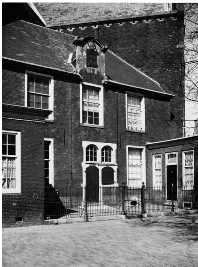
Afbeelding 7: aanbouw Noorderkerk met hergebruikt hout in kapconstructie (foto BMA).
