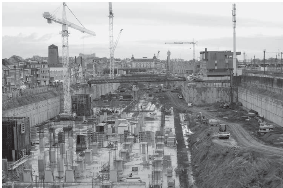
Afbeelding 7: Project Gent Sint-Pieters. De grootste bouwput van Vlaanderen, met op de achtergrond het oude stationsgebouw van Louis Cloquet (1910), moet op termijn een geheel nieuwe woon-, werk- en verkeersinfrastructuur rondom het belangrijkste station van de stad op gang brengen. Het project wordt door buurtcomités en door de milieubeweging sterk gecontesteerd. (Koningin Fabiolalaan, © Peter Stabel)
