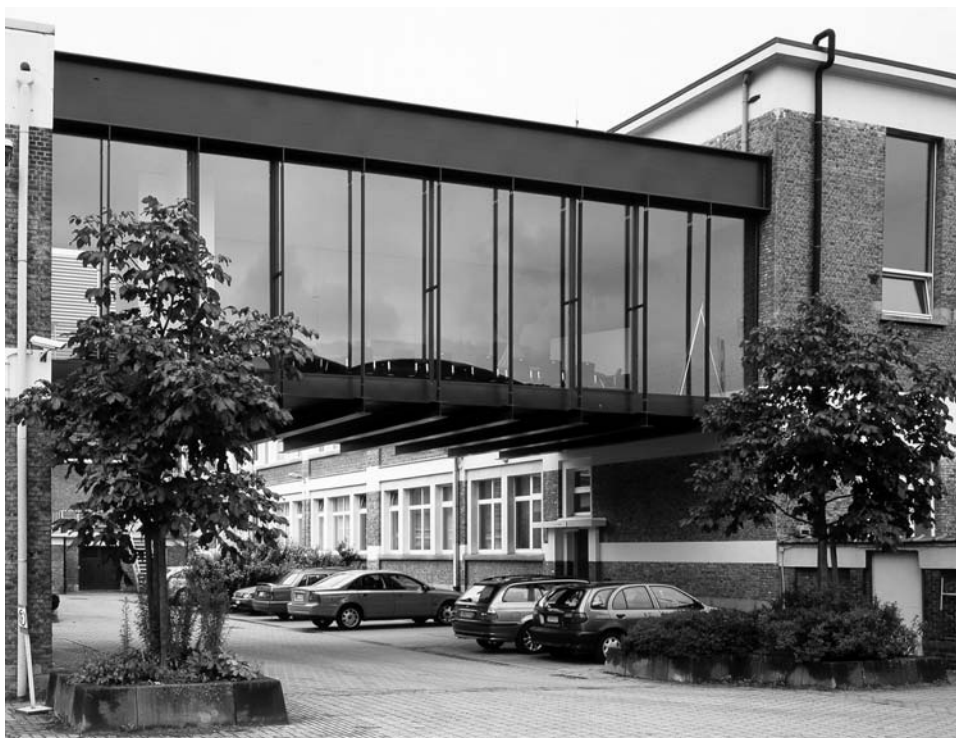
Afbeelding 1: Herinrichting van het waterbouwkundig labo in Borgerhout. Bouwheer: Afdeling Gebouwen van de Vlaamse Gemeenschap. Architecten: Architecten BOB361 bvba. Foto-graaf: Niels Donkers.
