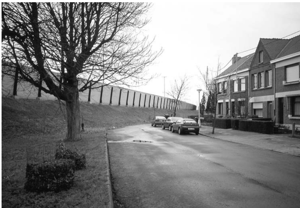
Afbeelding 3: Geluidsschermen aan de A12 in Ekeren. Bouwheer: Ministerie van de Vlaamse Gemeenschap, Afdeling Wegen en Verkeer. Fotograaf: Niels Donkers.
