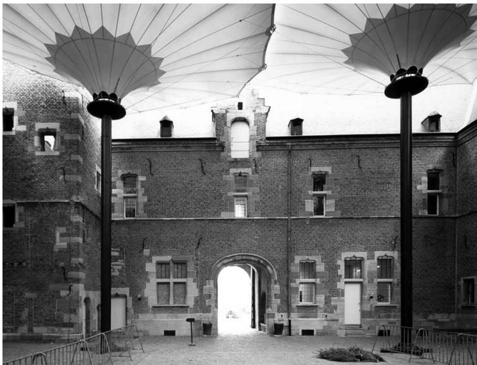
Afbeelding 4: Overkoepeling binnenplein kasteel Alden-Biesen, Bilzen. Opdrachtgever: Ministerie van de Vlaamse Gemeenschap, Afdeling Gebouwen Limburg. Ontwerper: Ney & Partners. Fotograaf: Niels Donkers.
