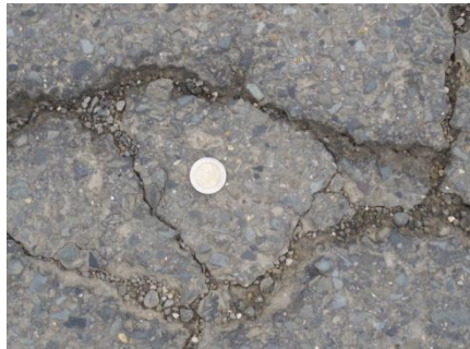
Scheurvorming
