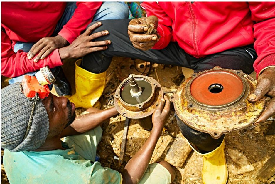
Figure 1. Réparation d'une pompe à eau (Crédit: Carrubba)
