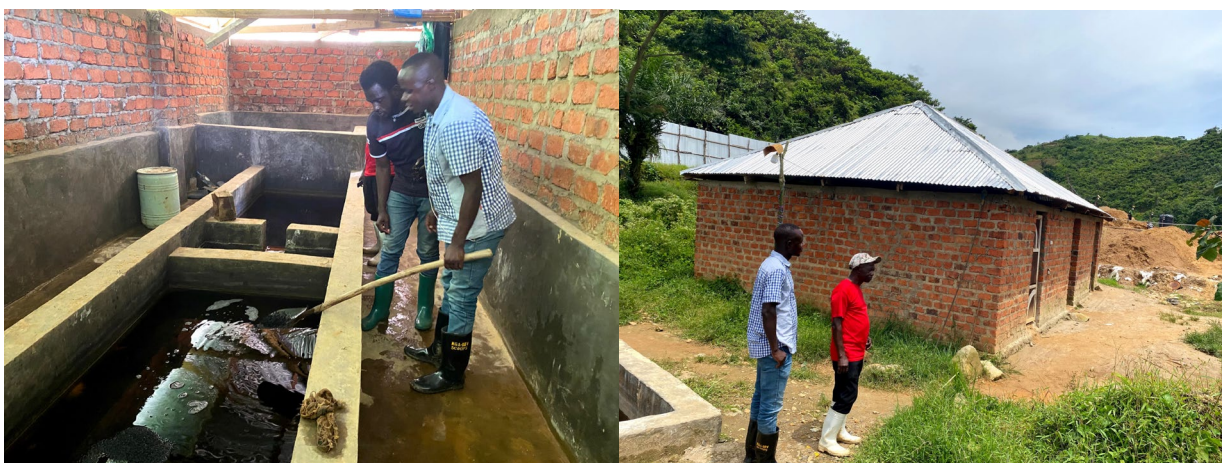
Figure 3 et 4: Unité de traitement au cyanure, dans un espace clôturé et mieux contrôlé.
