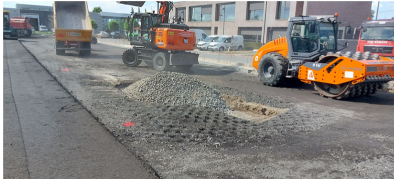
Figuur 53: aanvoer gebroken steenslag in uitgegraven gat
