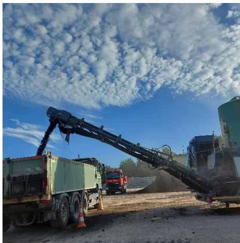
Figuur 43: vrachtwagen laden met BSM – proefvak 2
