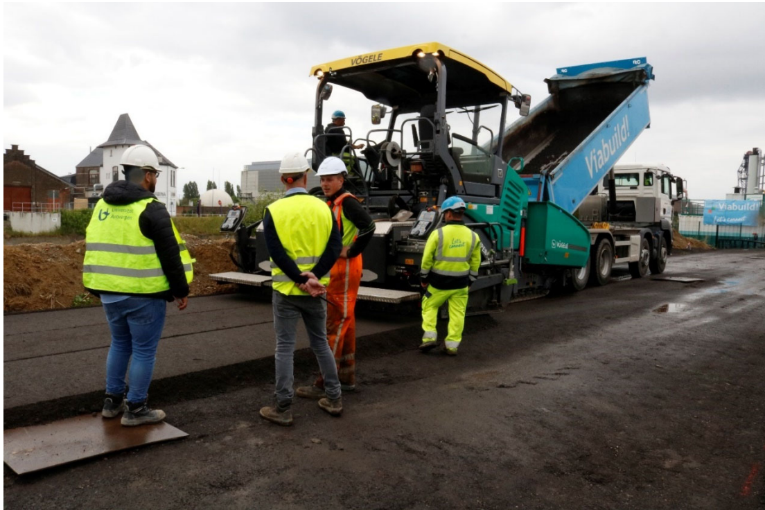
Figuur 14: aanleg BSM met asfaltspreidmachine – proefvak 1
