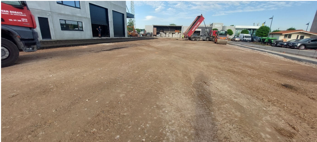
Figuur 39: foto onderfundering proefvak 2
