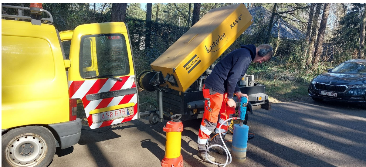
Figuur 1: uitvoeren van proefboringen
