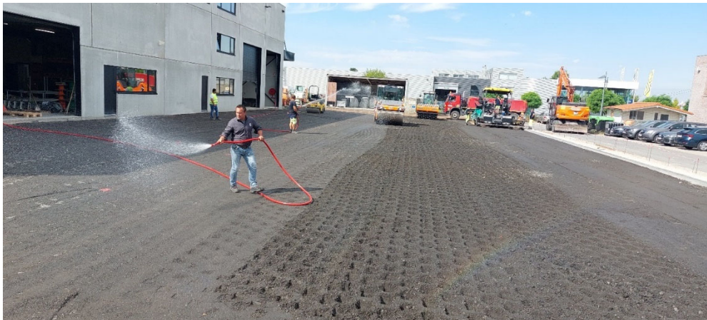
Figuur 47: bevochtiging tijdens het verdichten van BSM
