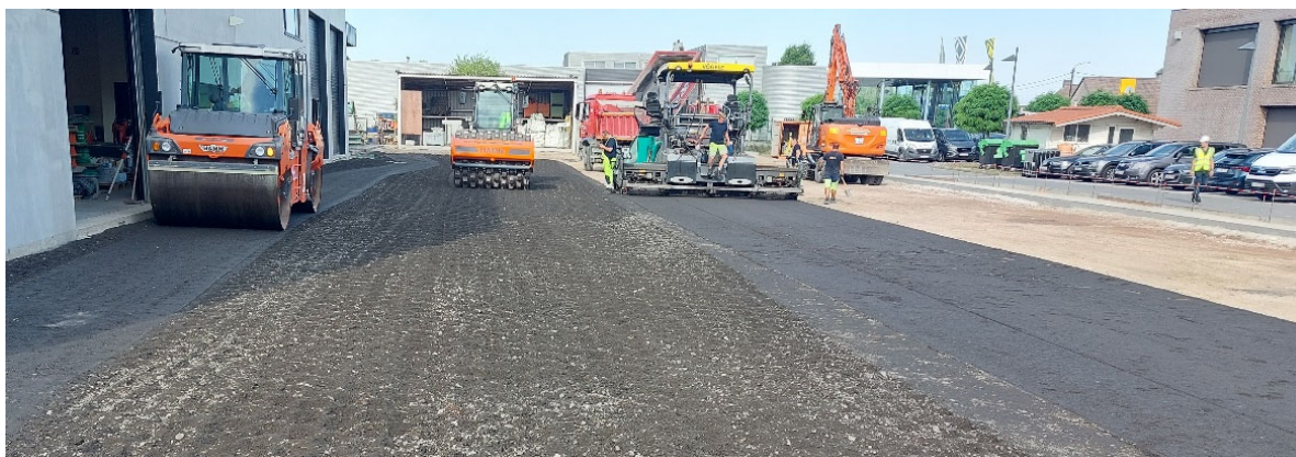
Figuur 45: aanleg BSM met asfaltspreidmachine – proefvak 2
