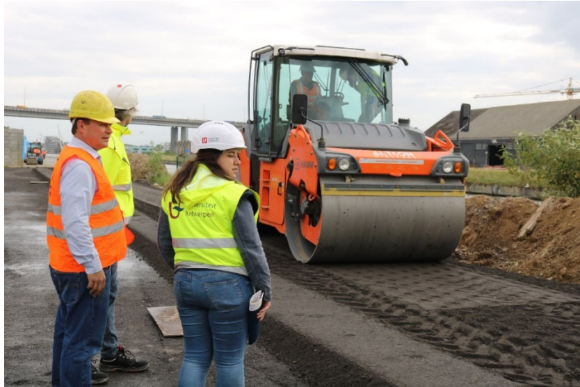
Figuur 18: tandemwals 12 ton – proefvak 1
