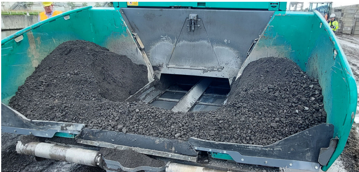
Figuur 15: segregatie in de hopper
