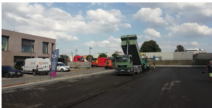
Figuur 44: vrachtwagen lost BSM in asfaltspreidmachine – proefvak 2
