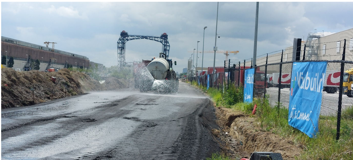
Figuur 13: bevochtigen van onderfundering met beerkar – proefvak 1
