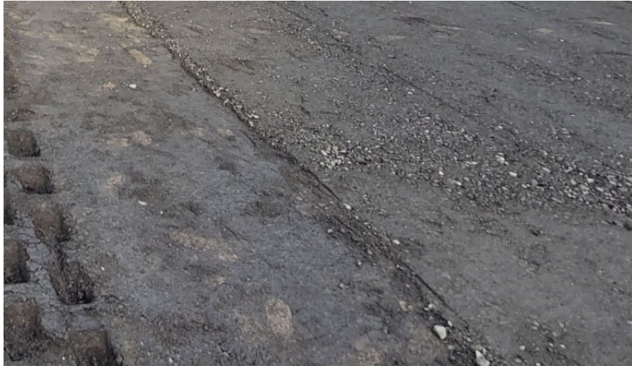
Figuur 16: vorming van nesten in BSM
