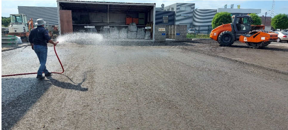
Figuur 46: bevochtigen onderste BSM laag – proefvak 2
