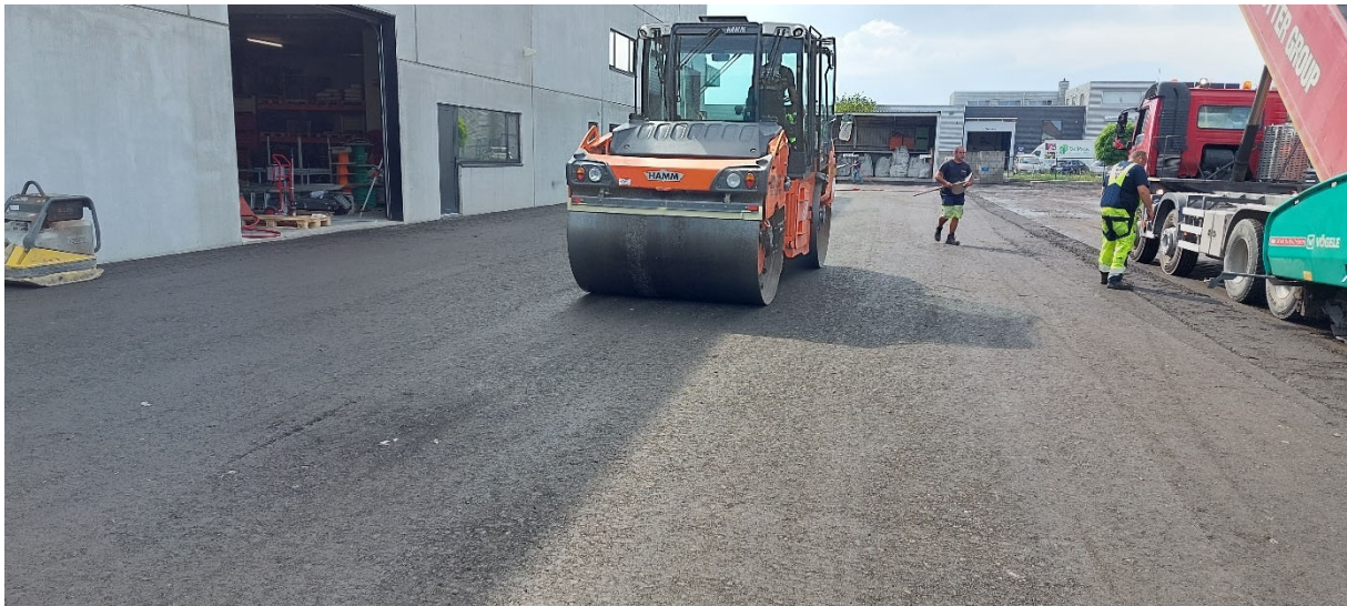
Figuur 49: tandemwals 12,5 ton – proefvak 2
