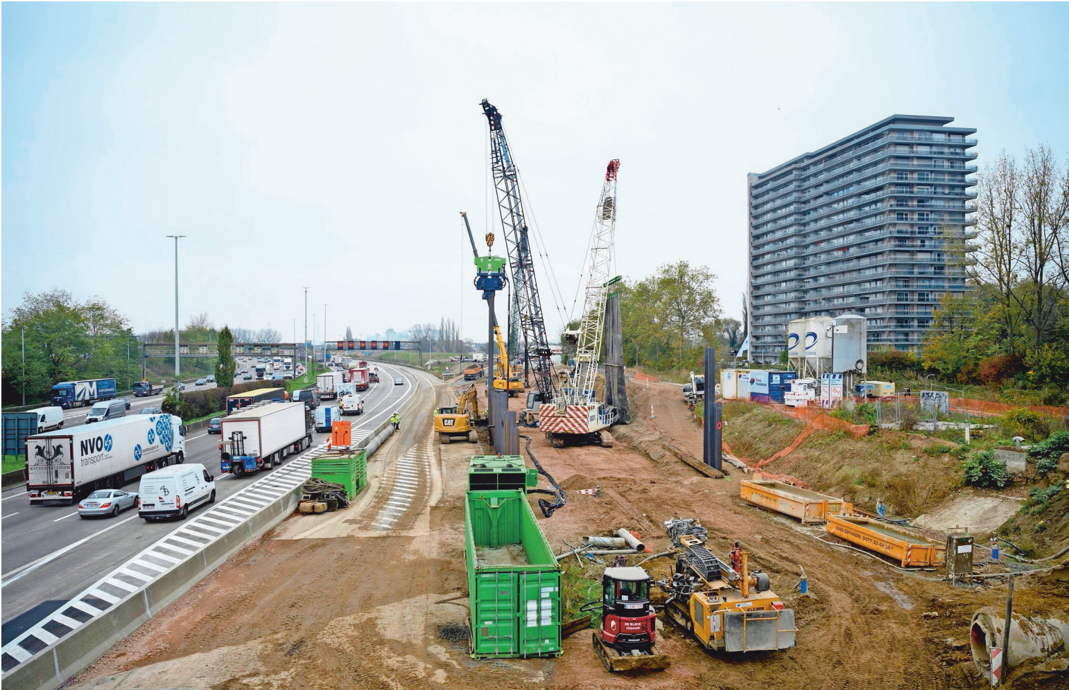
De Antwerpse ring, waar je wegens werken aan de Oosterweel-verbinding nog jaren op een stevig arsenaal aan graafmachines, bulldozers en vrachtwagens zult botsen. © KLAAS DE SCHEIDER
